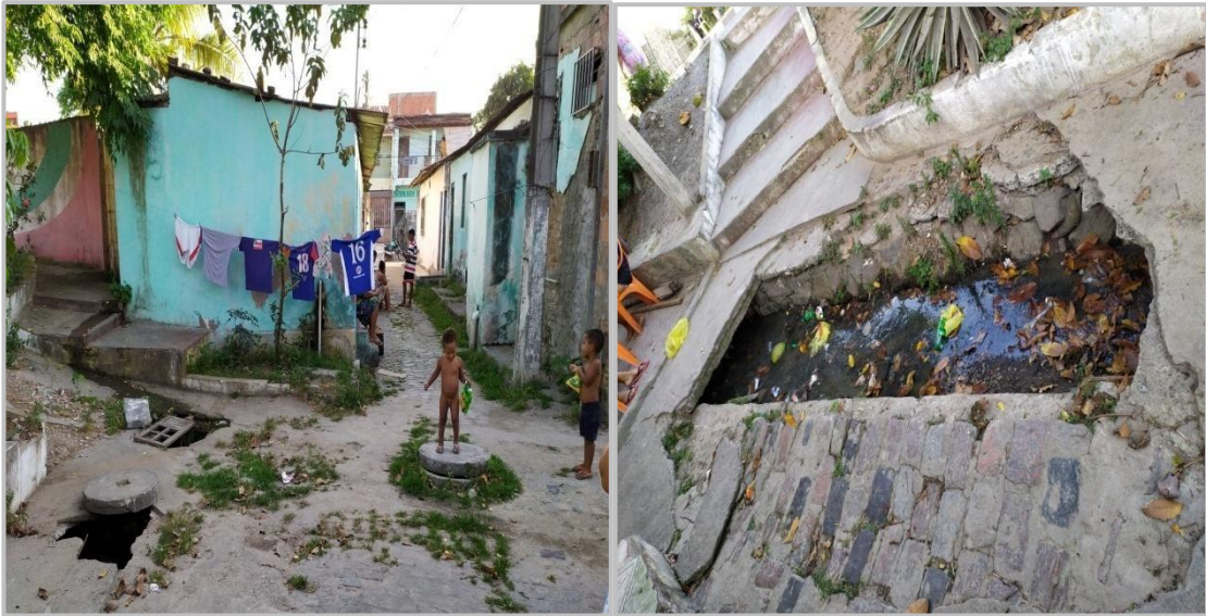
Figura 6 - Ponto crítico com esgoto a céu aberto, bairro Rua Nova, Feira de Santana-Bahia, nov./2019
