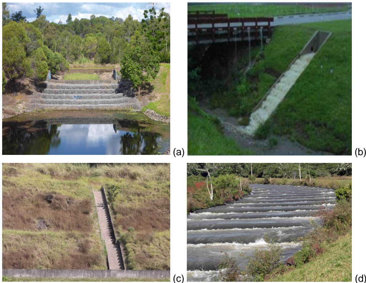
Figura 3 - Estruturas em degraus: a) Vertedouro em degraus em Robina, Gold Coast (Austrália), b) Canal em degraus utilizado no sistema de drenagem do Campus II da USP em São Carlos, c) Descida d'água em degraus em um talude de rodovia d) Canal da Piracema da Barragem de Itaipu no Rio Paraná.
