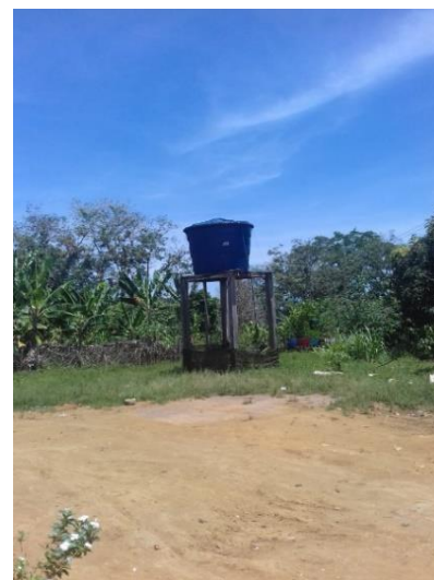
Figura 14. Reservatório elevado de distribuição para a agrovila Sede, P.A. Lucas Dantas.
