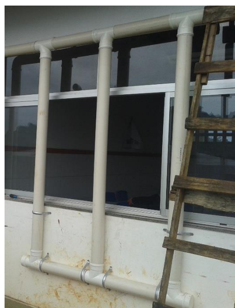
Figura 22. Separador da primeira água de chuva – decantador (2)
