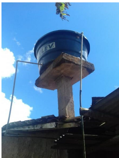
Figura 7. Reservatório de residência P.A. Josinei Hipólito
