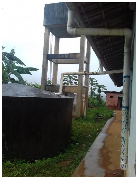
Figura 23. Separador da primeira água de chuva – decantador (1)
