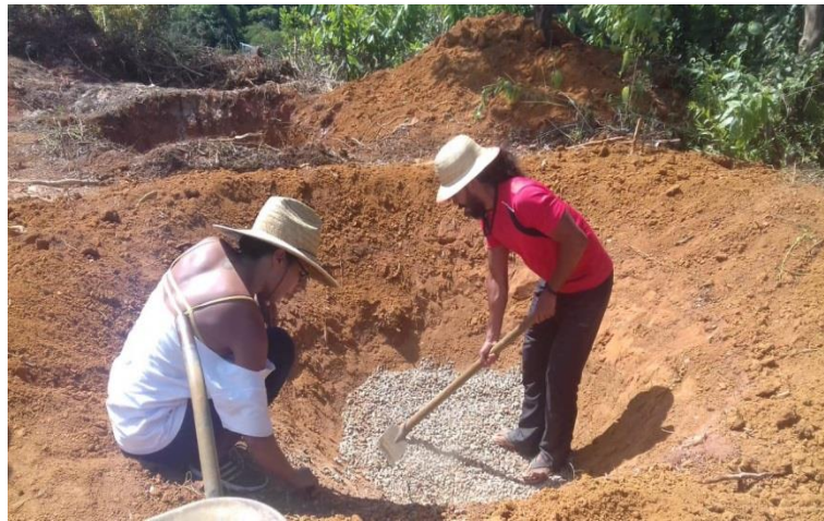
Figura 32. Primeira camada de material - brita
