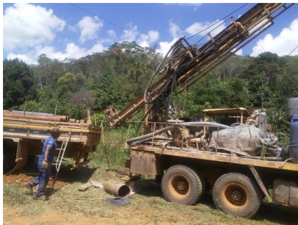
Figura 16. Maquinário para perfuração do poço no P.A. Lucas Dantas
