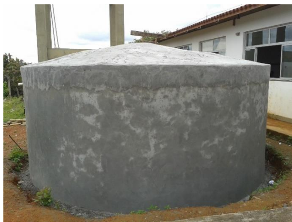
Figura 24. Cisterna de ferrocimento
