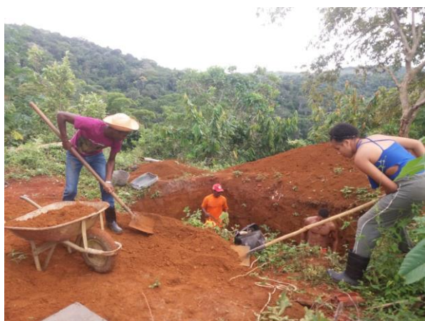
Figura 37. Mutirão de construção da câmara da BET
