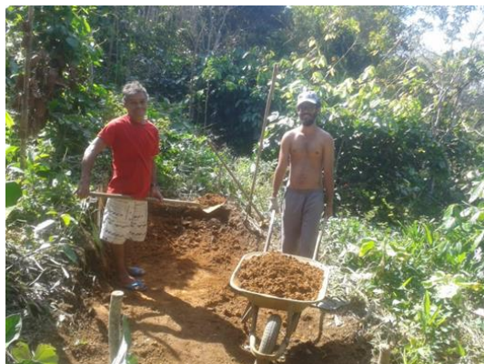
Figura 48. Escavação manual da vala para construção da BET
