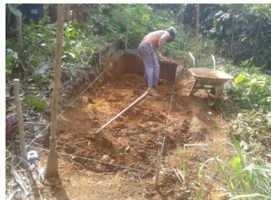
Figura 46. Vala para construção da BET na residência
