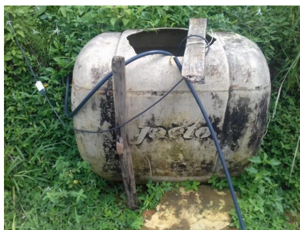
Figura 9. Reservatório intermediário da fonte e residência.
