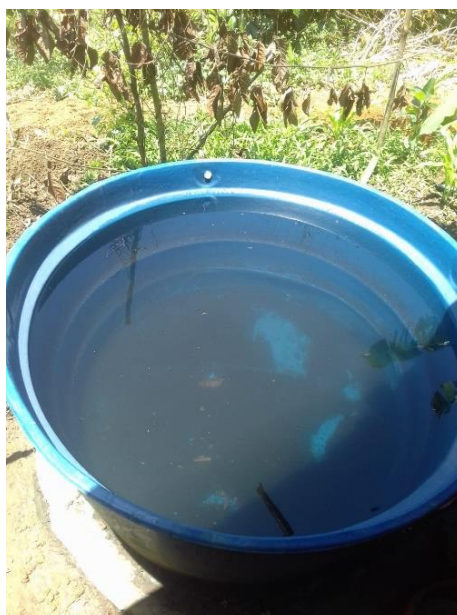
Figura 42. Resíduos ao fundo do reservatório.
