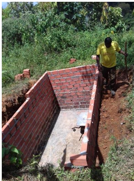
Figura 26. Estrutura da câmara - BET da ETALC.
