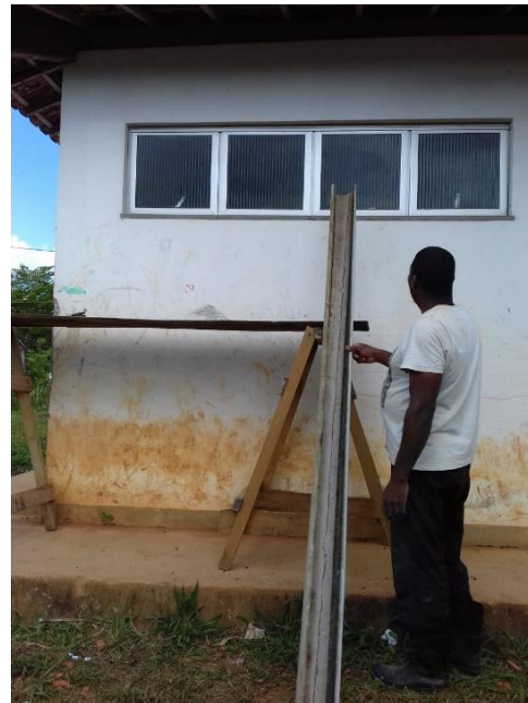
Figura 20. Manutenção das calhas, 2019.
