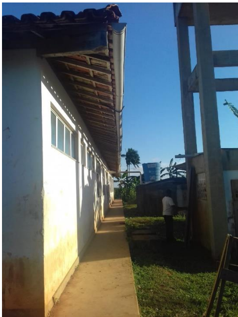
Figura 21. Telhado e calhas para captação da água de chuva
