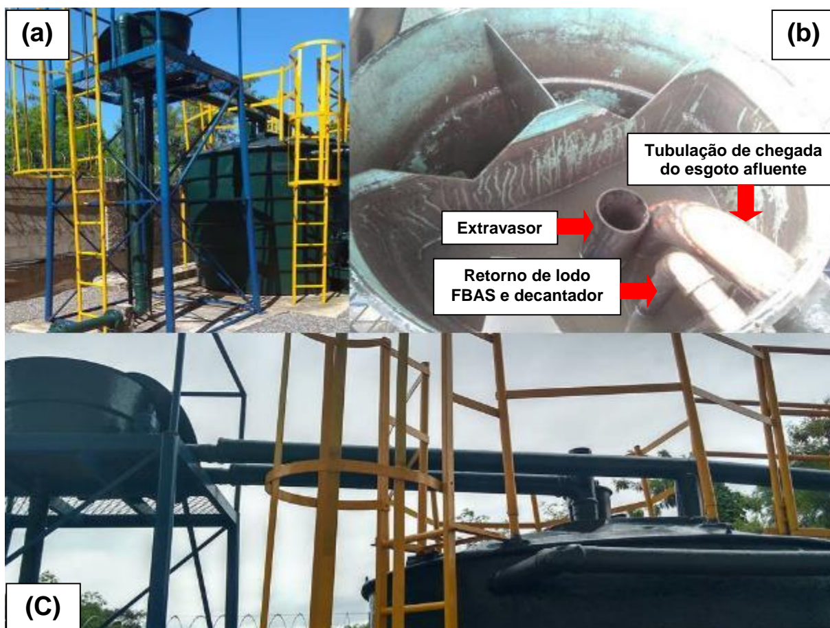
Figura 7 – Sistema de distribuição do esgoto aos reatores anaeróbios. Vista externa (a) e interna (b) da caixa de distribuição e tubulações de distribuição do esgoto afluyente aos reatores (c)
