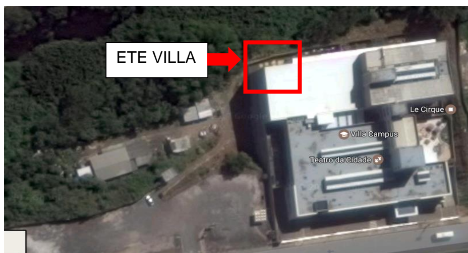
Figura 3 – Imagem aérea do local de implantação da ETE estudada
