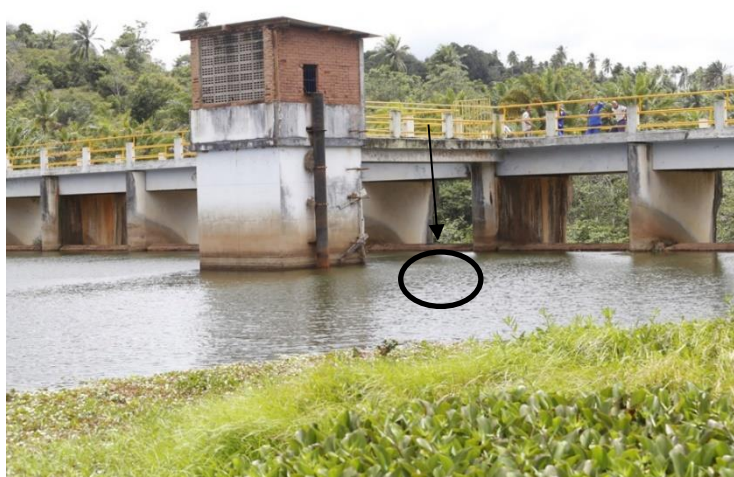
Figura 8 – Ponto de captação da água do manancial Joanes I.
