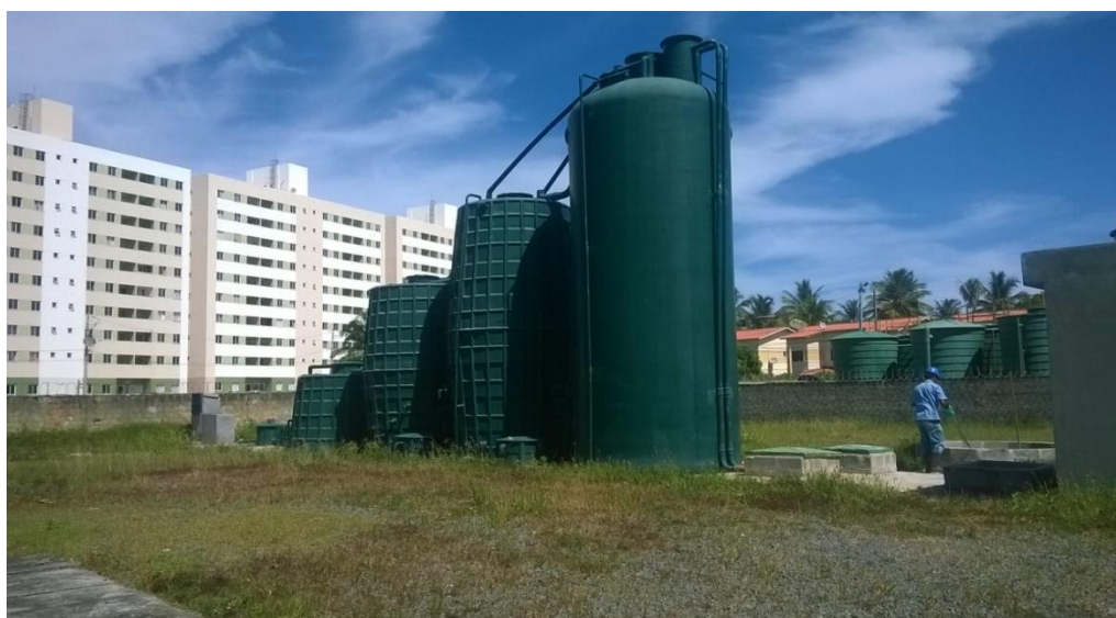
Figura 9 – Estação de Tratamento de Esgotos Especial.
