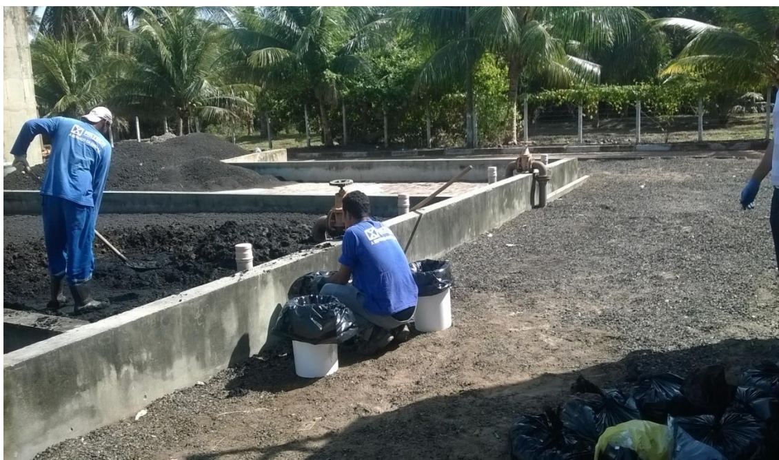
Figura 5 – Coleta do lodo anaeróbico no leito de secagem da ETE Iberostar.
