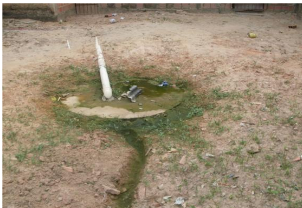
Figura 33 - Bacia 5 – Localidade Novo horizonte - ponto de ligação inadequada de águas servidas na rede de drenagem - PAC1
