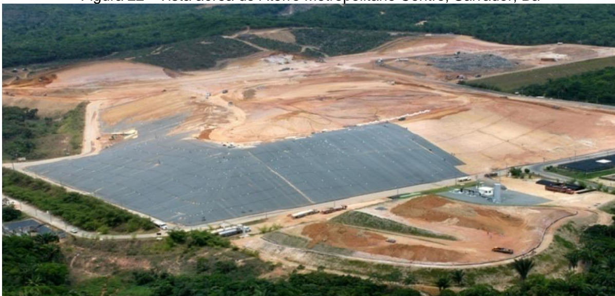
Figura 22 - Vista aérea do Aterro Metropolitano Centro, Salvador, Ba
