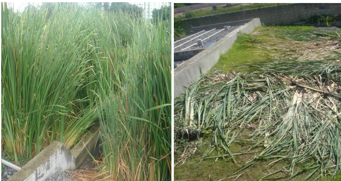
Figura 27 - Necessidade de poda e disposição da biomassa gerada na ETE
