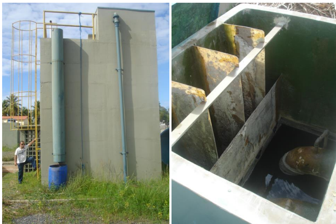
Figura 10 – Vista do reator UASB (esquerda) e da caixa de divisão de fluxo (direita)
