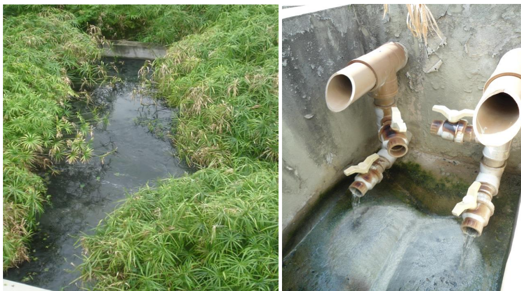
Figura 28 - Formação de biofilme na caixa de saída (direita) e elevação do nível do efluente dentro dos wetlands construídos (esquerda)
