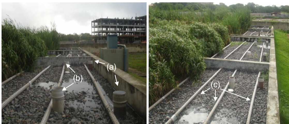
Figura 12 - Leito de distribuição do afluente com destaque para as tubulações de chegada do afluente (a), retirada de lodo (b) e recirculação do efluente (c)
