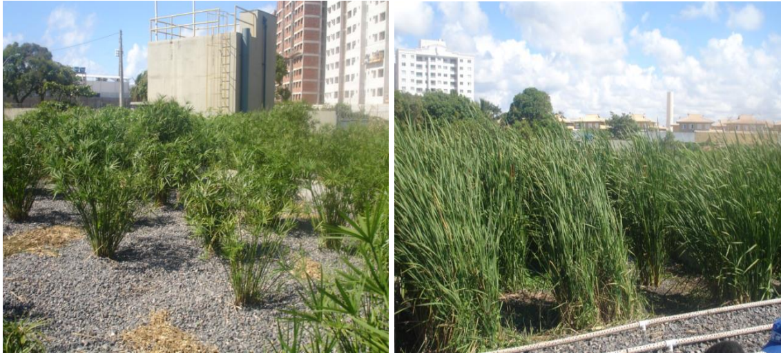
Figura 13 - Leito filtrante (Leito de desenvolvimento das macrófitas)
