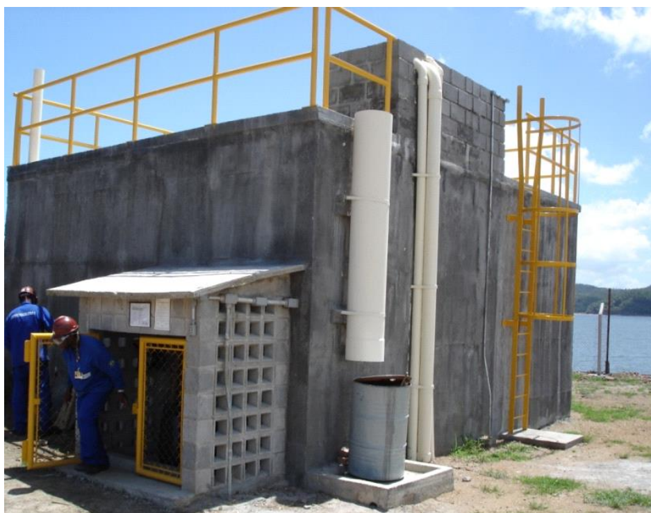
Figura 2 - Vista de um reator UASB
