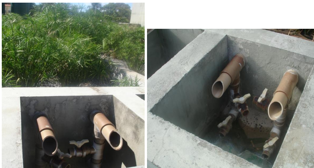
Figura 14 - Caixa de coleta do efluente
