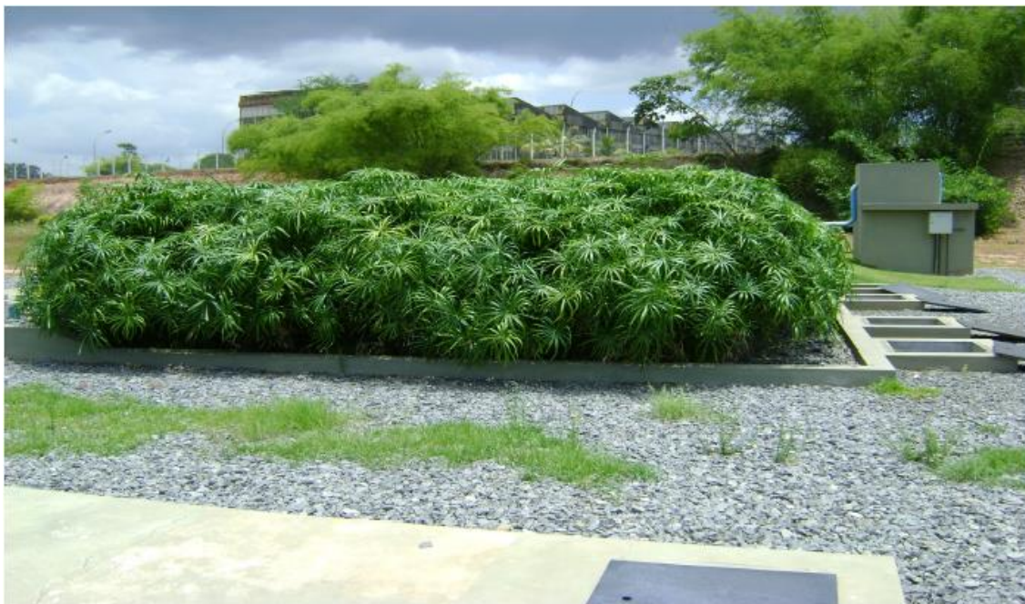
Figura 3 - Vista de um wetland construído.
